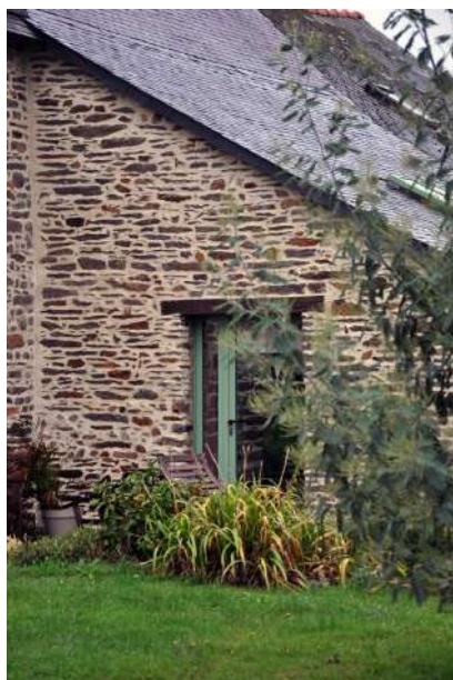
Ravalement façade (Source : LePierre Maçonnerie)
